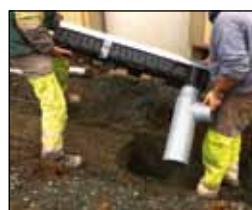
Установка песколовки
