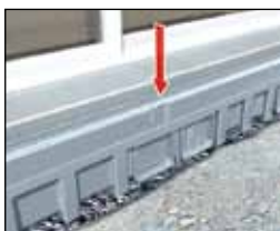
Бетонирование и укладка покрытия
