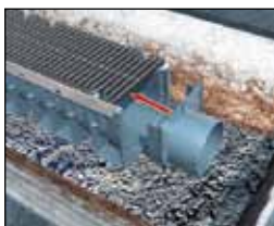
Герметизация соединений
